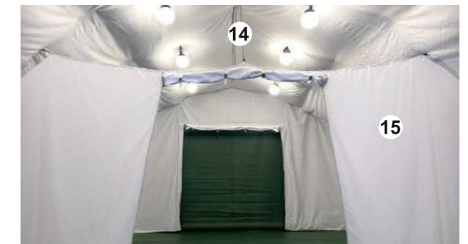
14. **Освещение** внутреннего пространства обеспечивается с помощью двух линий светильников.
